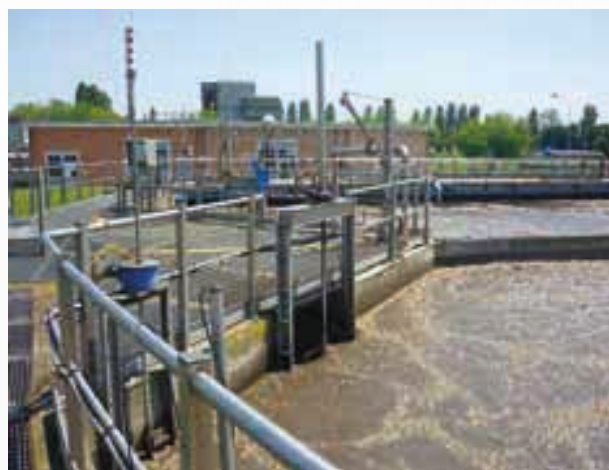
La vasca di depurazione.
